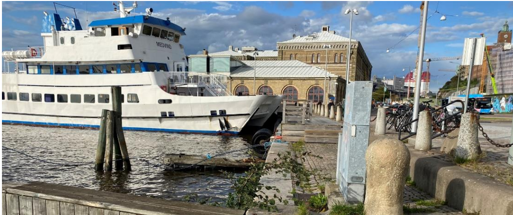
Figur 30 Lägare parti av kajen mellan svängbron och den renoverade kajen. Kajkant, gatsten och pollare i granit.
